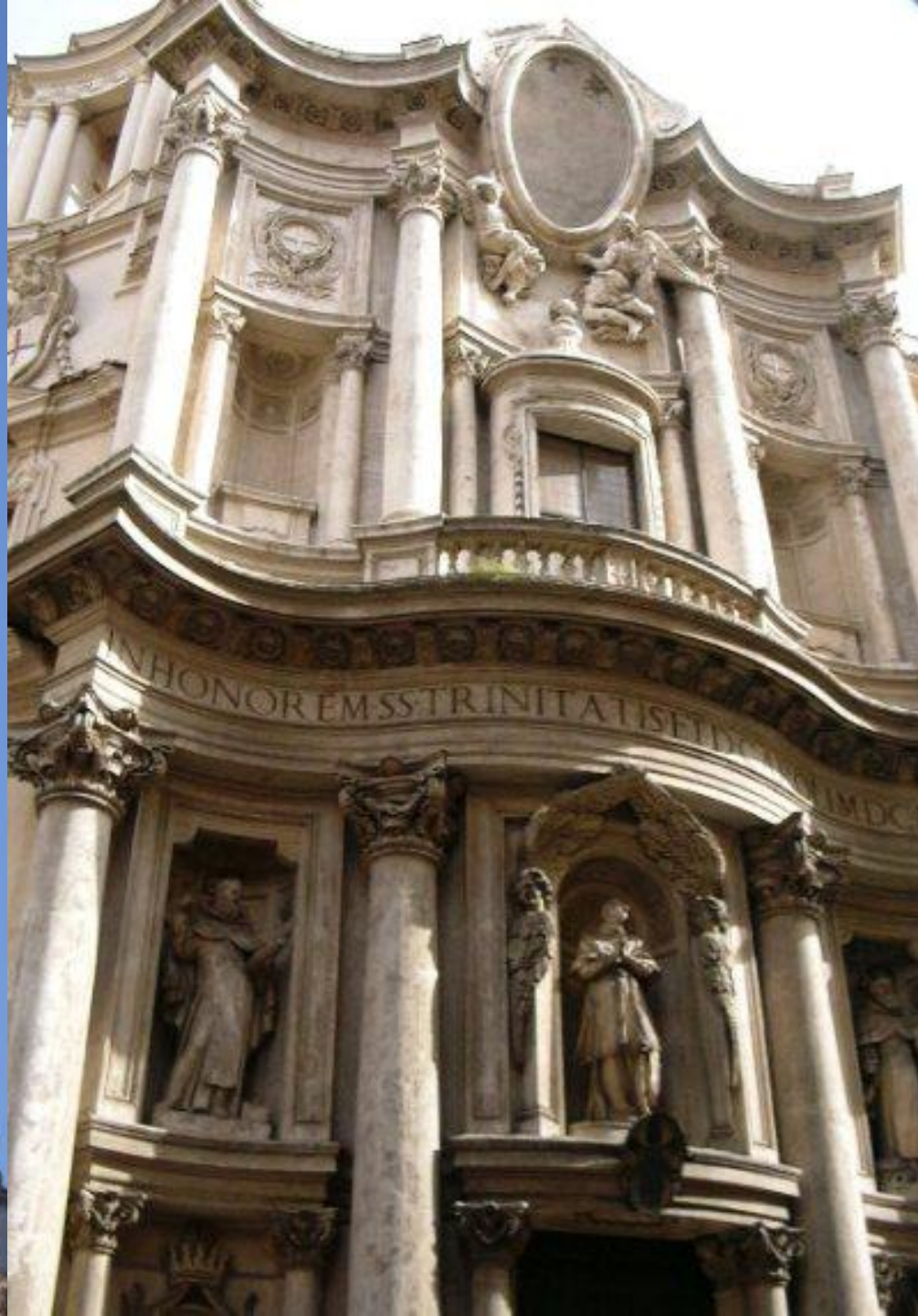
San Carlo, Rome. Borromini. 1665-1667
